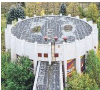
Für die Rote Armee gebautes Haus der Offiziere in Wünsdorf
